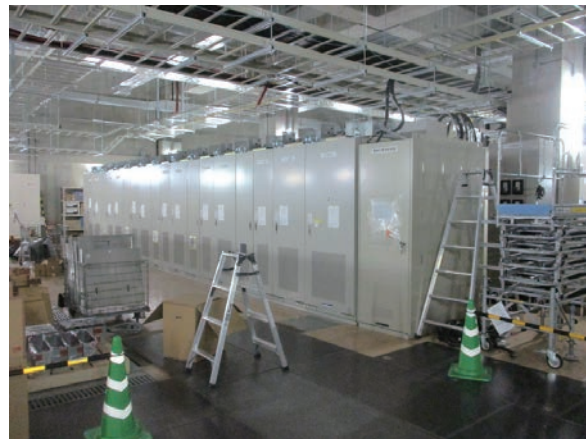
図 2：更新した主電磁石電源（QDN 電磁石電源）
