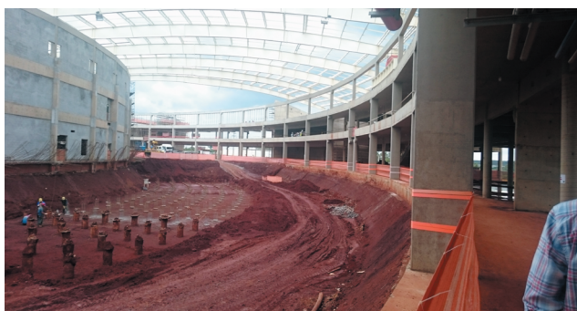
写真 3: 建設中の Sirius の内側
