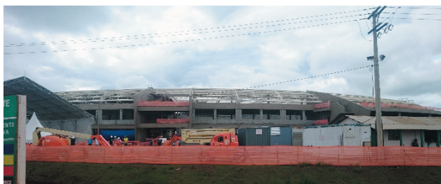
写真 2: 建設中の Sirius
